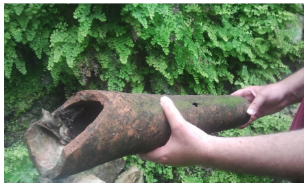
Fistula della caladria rinvenuta dal proprietario, presso la limonaia de La Malora ( L = 55 cm).
