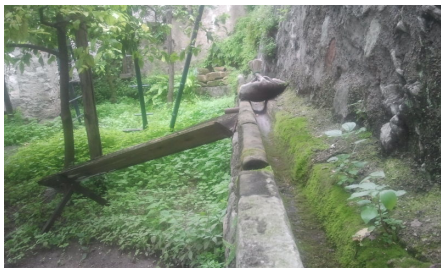
Diedro per accompagnare l'acqua al piede della pianta, ricostruito.
